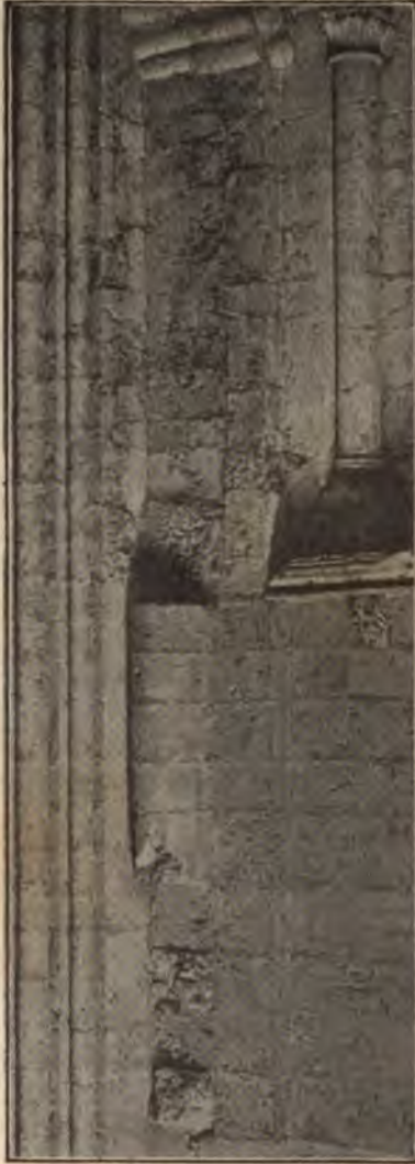
COLONNE D'ANGLE DU CLOCHER SUD
